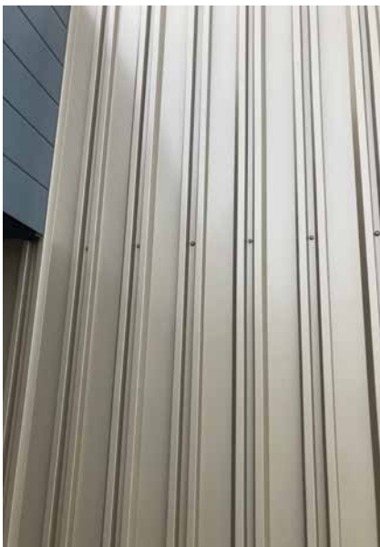
Project: Accomodatie Montfoort SV'19 › Architect: Edgar Vendrig › Montage: Metal Bouwkonsort › Producten: SAB-Merlon 30/415-100 in Colorcoat Prisma® Ephyra
