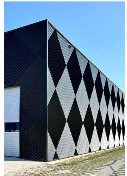
Project: Bergelijk Spa Plus › Montage: Kempen Cladding › Producten: SAB-Pyramid 50/440 in Colorcoat Prisma® Black
