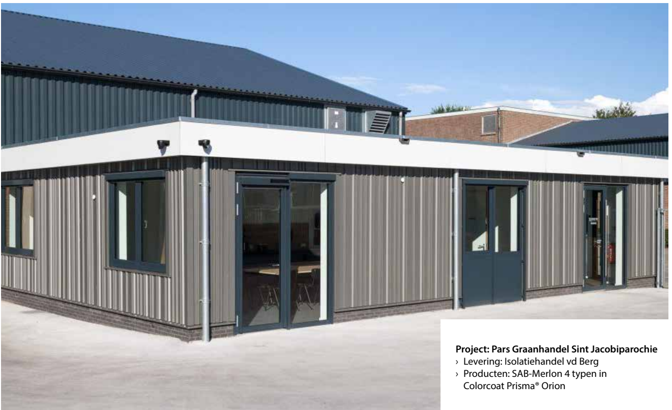
Project: Show Rental Hilversum › Montage: van Norel Systeembouw › Producten: SAB-Merlon 4 typen in Colorcoat Prisma® Seren Copper
