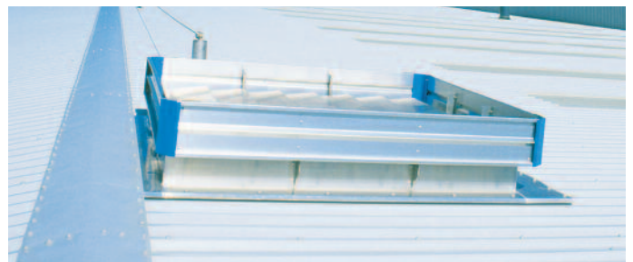
Durchbruch in der Dachdeckung
