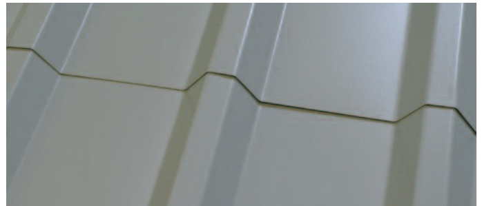
Schnittkante an einer Dacheindeckung
